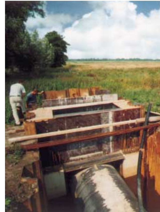
Door deze duiker onder het Noord-Willemskanaal stroomt straks het water van de Drentse Aa weer naar zijn oude loop door de polders.
