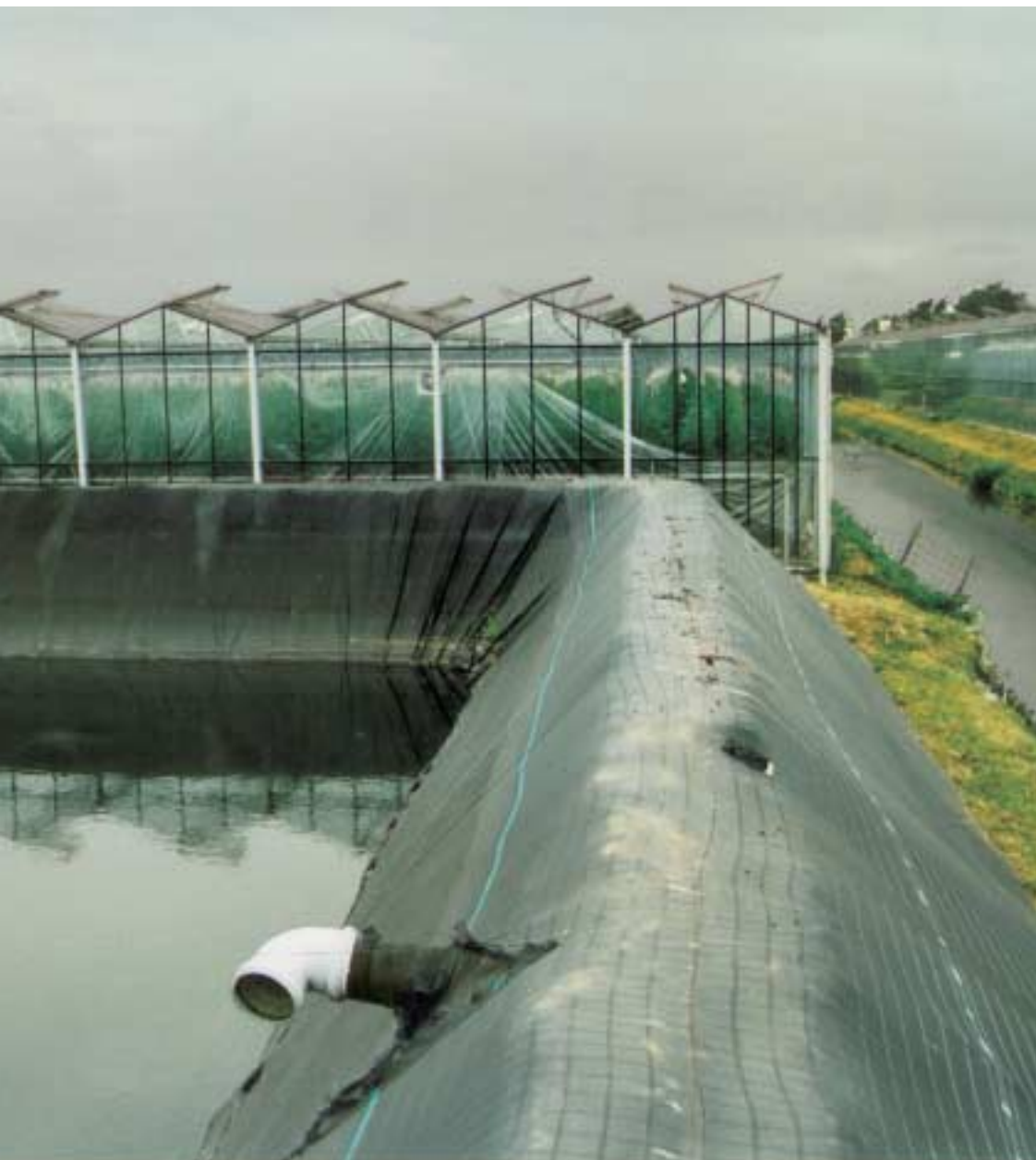
De kas, het gietwaterbassin en de sloot, drie hoofdrolspelers in een successtory.
